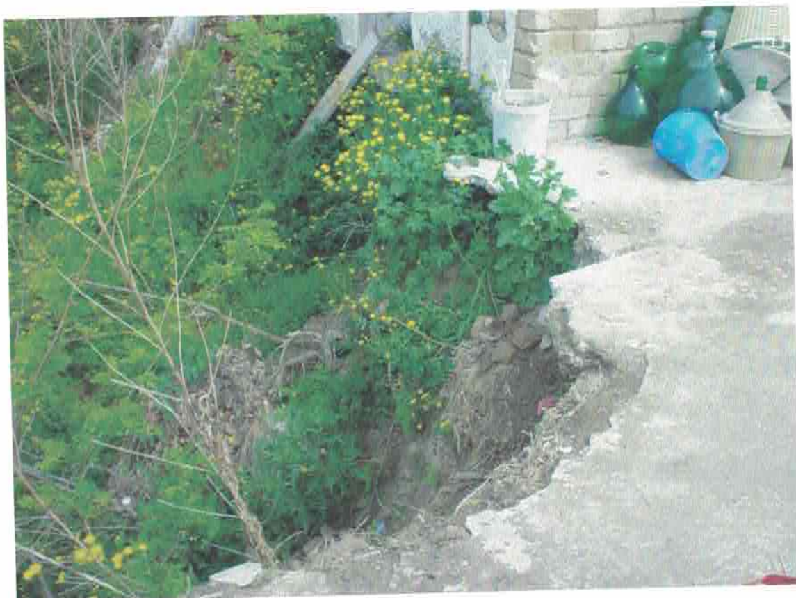
La frana della figura precedente lambisce anche una casa rurale sottostante la villa e ha già provocato il crollo della pavimentazione di uno spazio esterno
